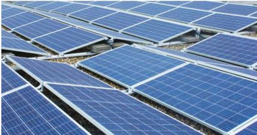
Instalación placas solares
