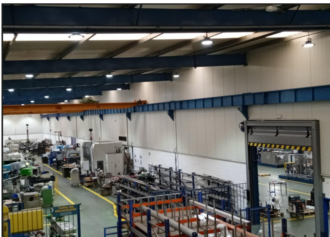
Instalación de nuevas luminarias y puerta rápida para mejora energética
