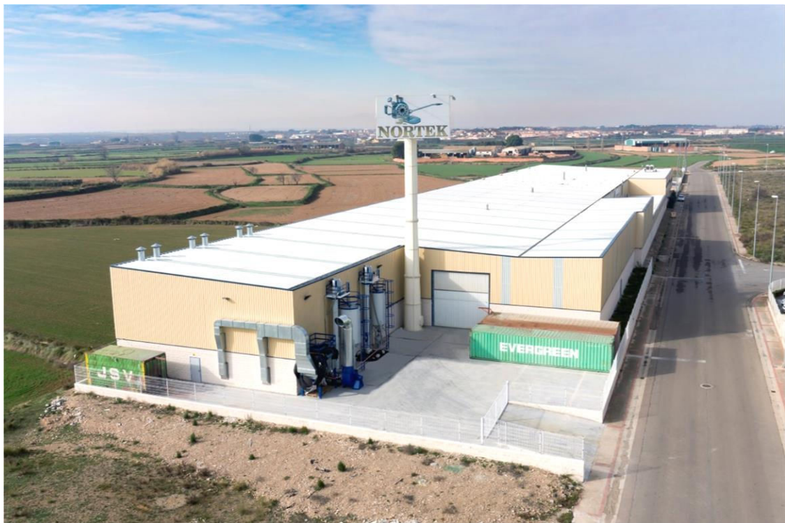
Instalaciones de Nortek en Pinseque (Zaragoza)
